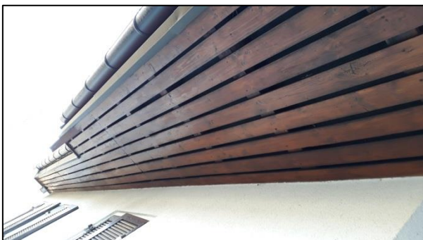
Abbildung 10: Verblendung des Dachvorsprungs des Wohnhauses mit Holzplanken.
