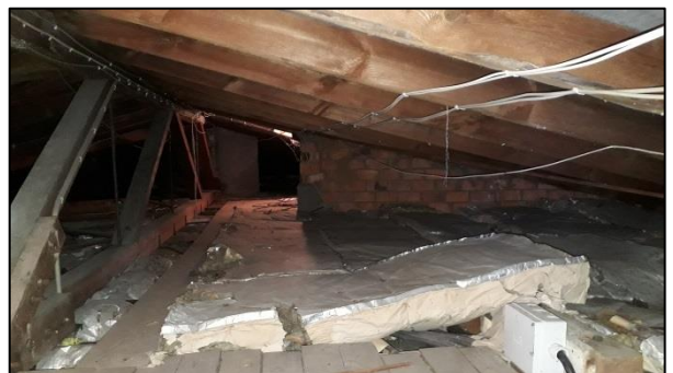
Abbildung 11: Isolierter Dachstuhl des Wohnhauses.
