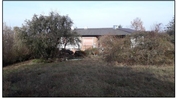
Abbildung 5: Nördlicher Bereich des Gartens, mittig leeres Wasserbassin, Wohnhaus im Hintergrund.
