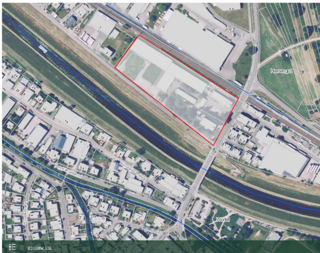
Abbildung 1: Lage des Planungsgebiets im Norden Kuppenheims (rot). Südlich verläuft die Murg, nördlich die Stadtbahntrasse. Quelle: Daten- und Kartendienst der LUBW.
