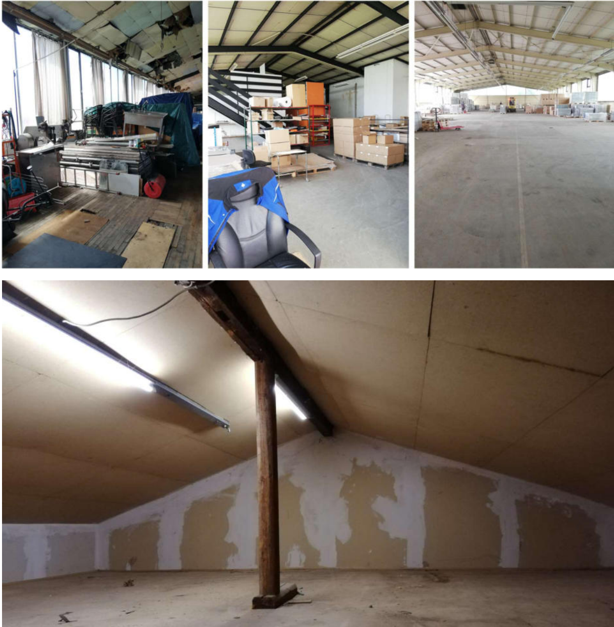
Abbildung 2: Untersuchte Hallen und Dachboden des ehemaligen Wohnhauses.
