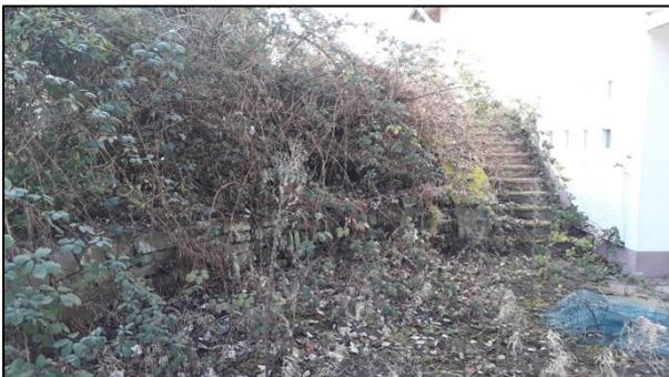
Abbildung 8: Mit Brombeere überwachsene Mauer und Treppenaufgang am Wohnhaus.
