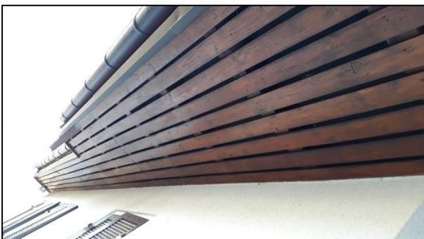
Abbildung 10: Verblendung des Dachvorsprungs des Wohnhauses mit Holzplanken.
