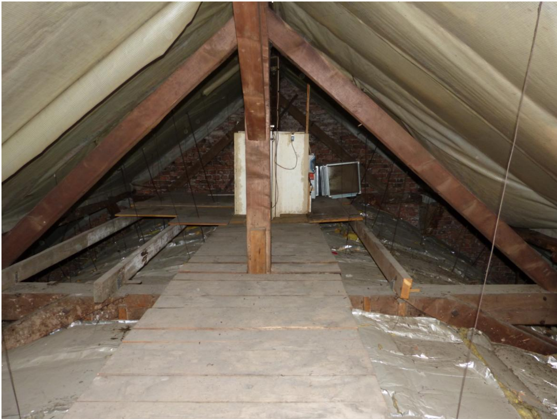
Abb. 2: Dachboden über der Kuppelhalle (dieser Teil des Altgebäudes soll abgerissen werden)
