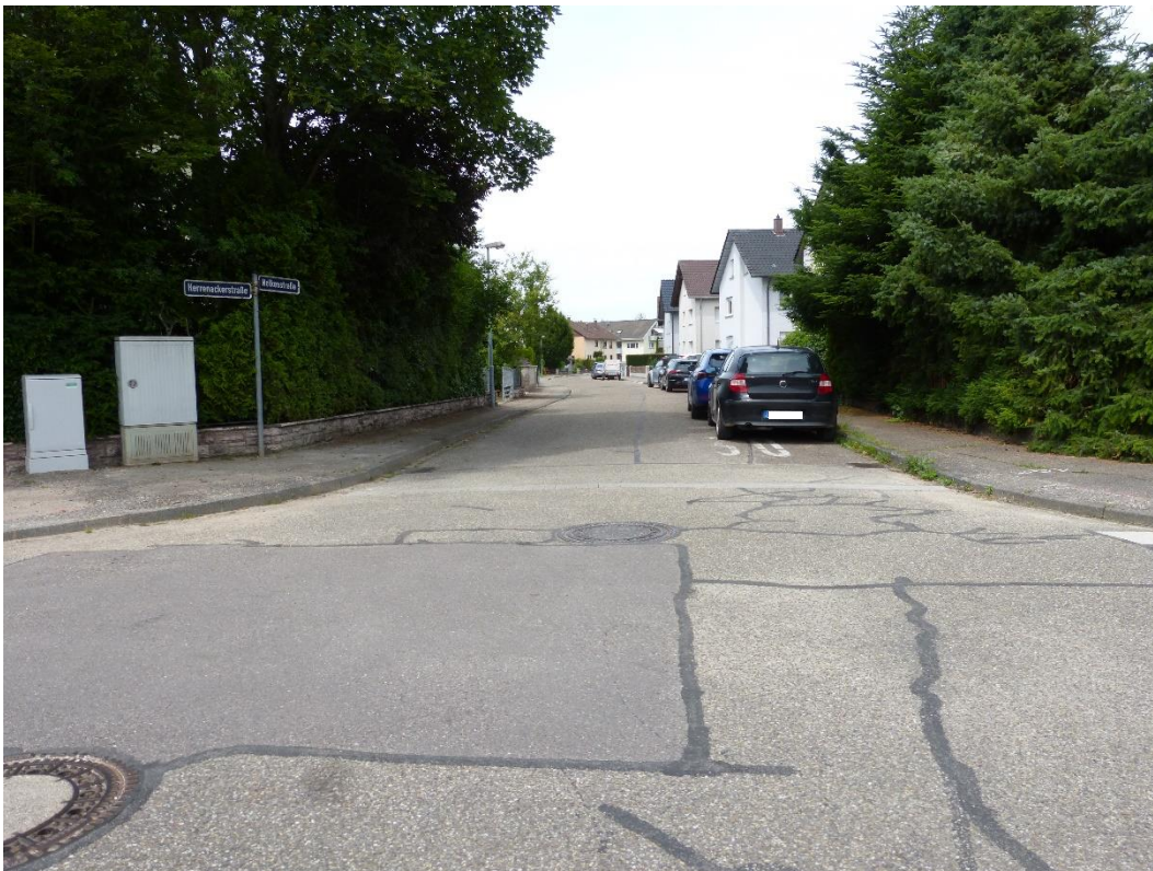
Bild 2: Blick von der Herrenackerstraße in die Nelkenstraße.
