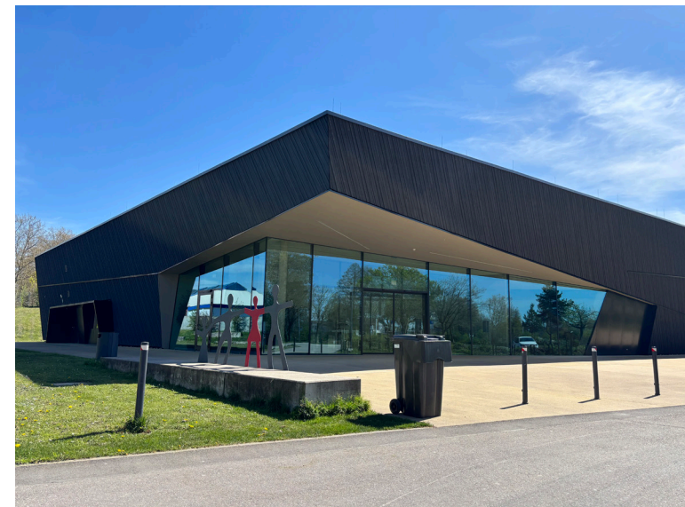
Veranstaltungshalle Kuppenheim | Foto: die STEG
