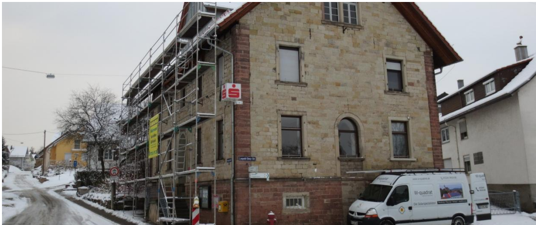
Die Firma W-Quadrat bei der Installation der neuen Anlage
